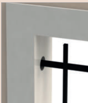
Scellement en tableau (standard)
