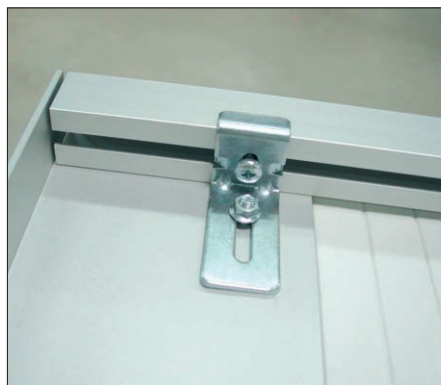
Détail liaison barre de battue haute/tapée cornière
